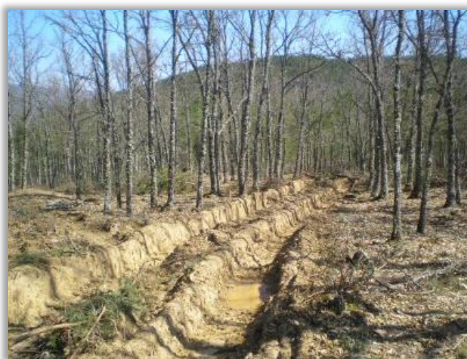
Imagen 2: Se observa el mal estado de una vía de saca que debe ser restaurada.
