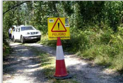
Imagen 1: Señalización de trabajos forestales en ejecución.
